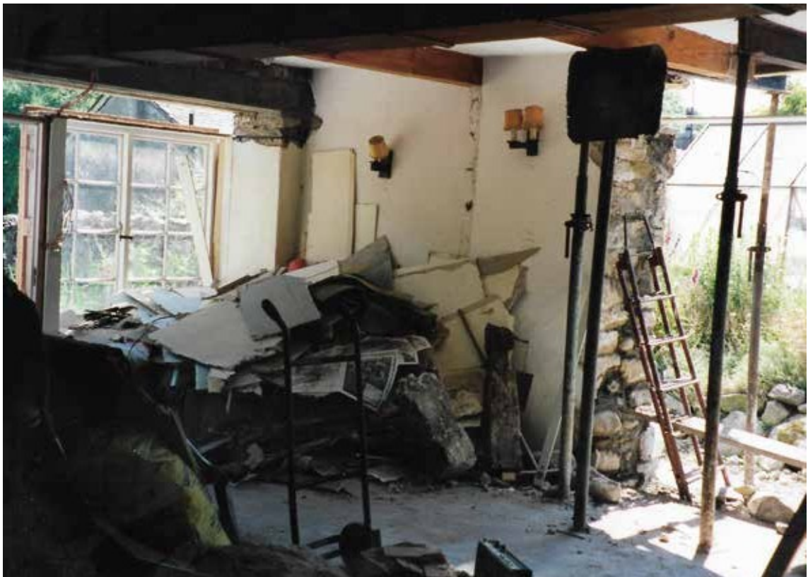
Renovering af hus, 1995-1996
